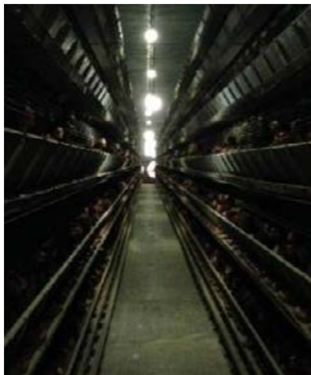
Рисунок 18. Светодиодные лампы, установленные в этом птичнике, имеют выраженную направленность, расположены слишком далеко друг от друга и недостаточно яркие. Совокупность этих факторов приводит к образованию тени на полу и к неоднородной освещенности вдоль клеточной батареи.
